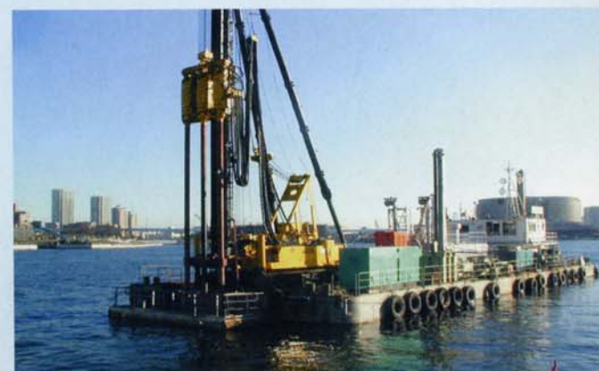
施工中の原位置固化処理船
