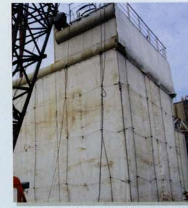
汚濁防止枠(膜全景)
